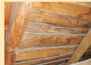
Sutakbord frå Tyssen med synlege skår frå oppgangssaga. FOTO: ATLE O. BOLSTAD.
